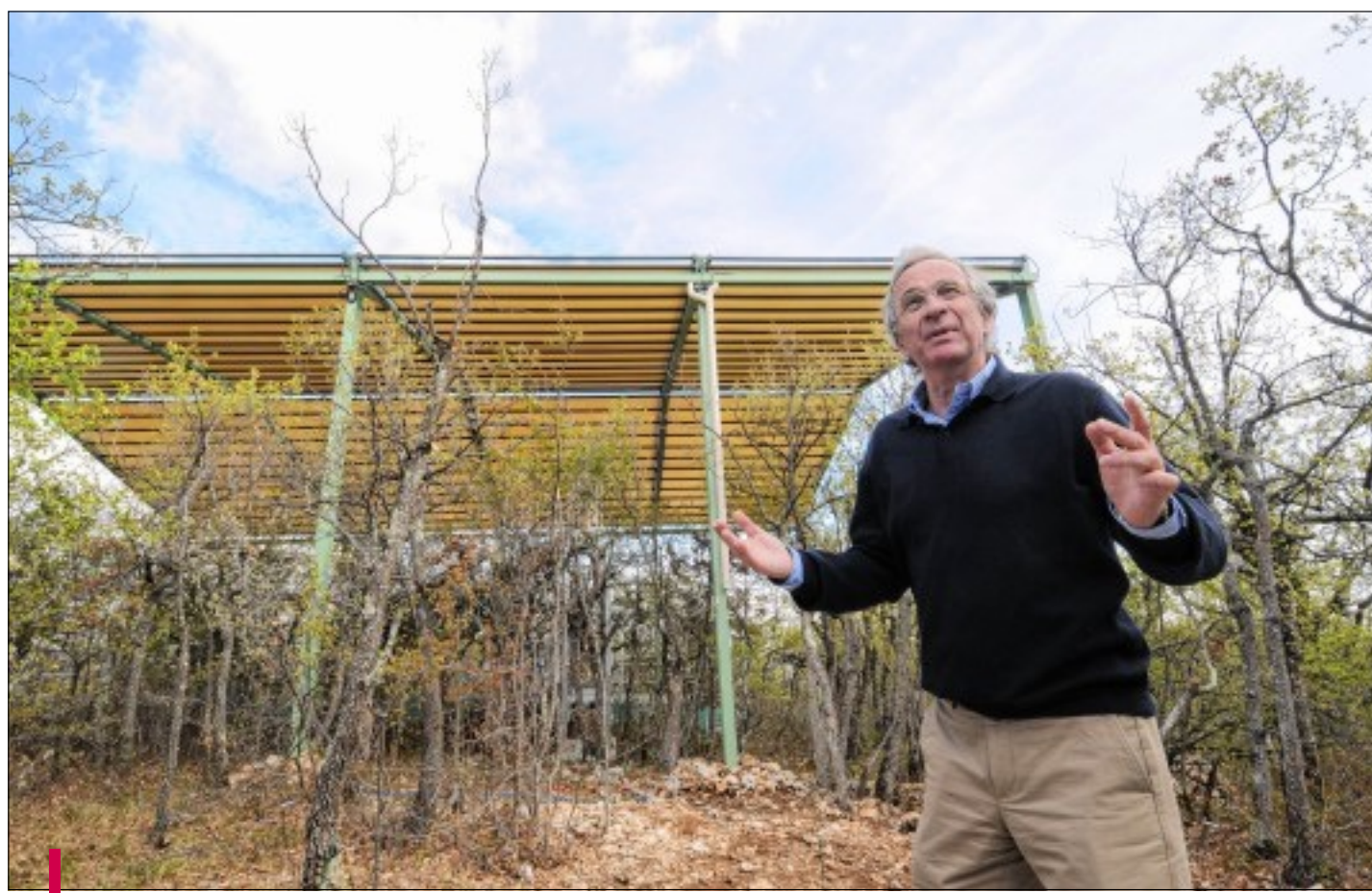
Un système automatisé d'exclusion de la pluie a été installé afin de protéger la canopée des arbres.
